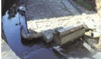
自然循環型水処理システム：水田の水浄化機能を手本に、本来自然が持っている物質循環の仕組みを活かした新しい水処理システム。河床の下に何層かに分けて、木炭や枯れ葉、石など自然素材を加工した充填材を配置し、微生物によって水をきれいにしている。このシステムは、四万十町内に13基設置されている。
