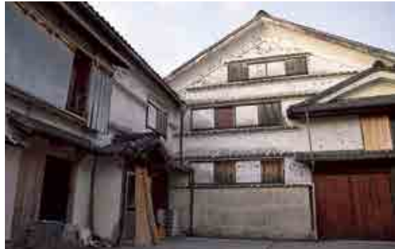
水切り瓦と土佐漆喰の酒蔵。 戦時中の空襲をさけるために黒く塗られた跡が残っている。
